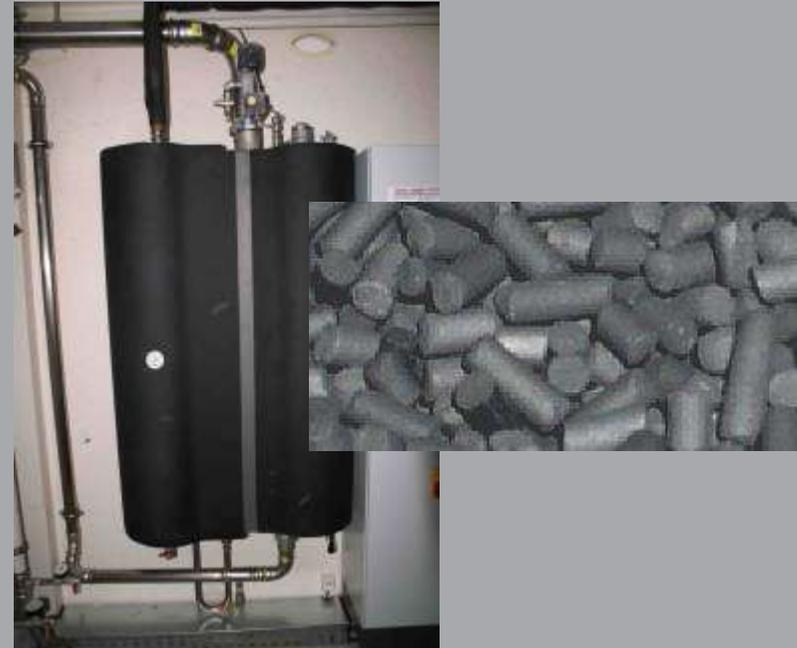
Le CHARBON ACTIF possède une structure poreuse et une grande surface d'échange de l'ordre de 1 000 m<sup>2</sup>/g. Les molécules à traiter sont retenues en surface, adsorbées par des interactions physiques. La capacité d'adsorption dépend des caractéristiques du charbon actif employé ainsi que de la température et de l'humidité de l'effluent à traiter.
